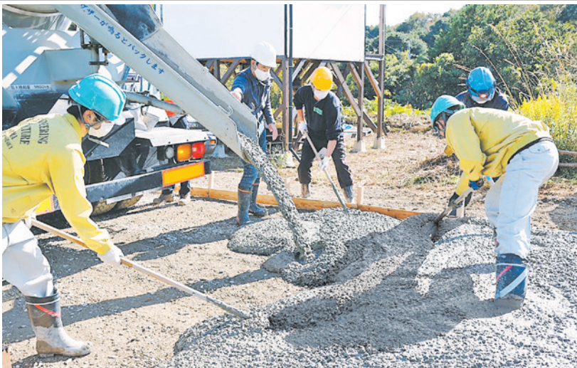
▲型枠を設置し、生コンクリートを敷く
