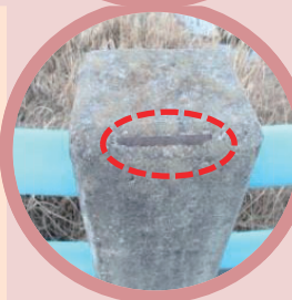
欠損・鉄筋露出(地覆)
