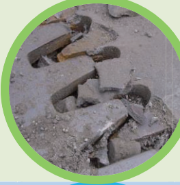
破損(伸縮装置)
