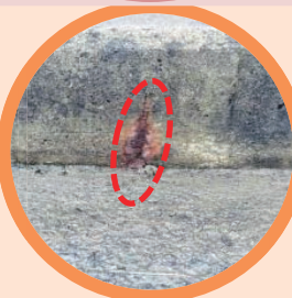
欠損・鉄筋露出(地覆)
