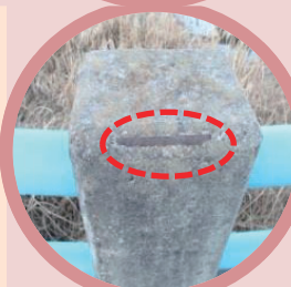
欠損・鉄筋露出(地覆)
