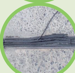
破損(伸縮装置)
