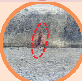
欠損・鉄筋露出(地覆)
