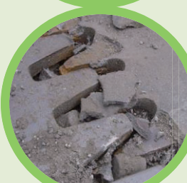
破損(伸縮装置)
