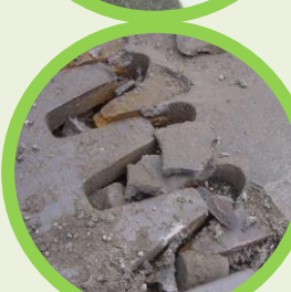
破損(伸縮装置)
