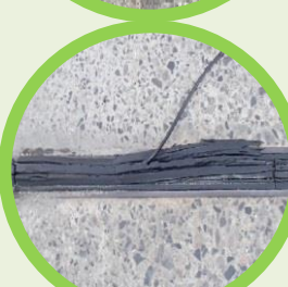
破損(伸縮装置)
