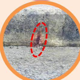
欠損・鉄筋露出(地覆)
