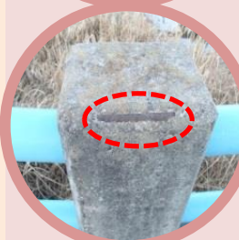
欠損・鉄筋露出(地覆)
